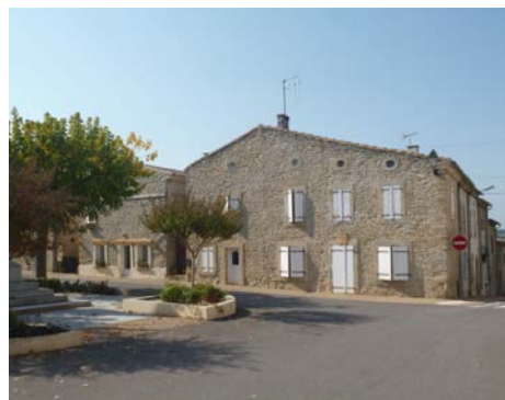
Traitement des encadrements des ouvertures et des chaînes d'angle distinct, toiture avec présence de gènoises, Rue de Saint-Amans
