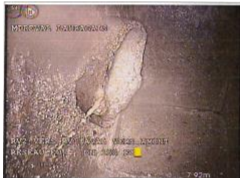
Raccordement ouvert par piquage direct buriné
