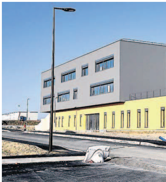
Le nouveau centre de formation des apprentis est en voie d'achèvement. / Photo N.A.-V.
