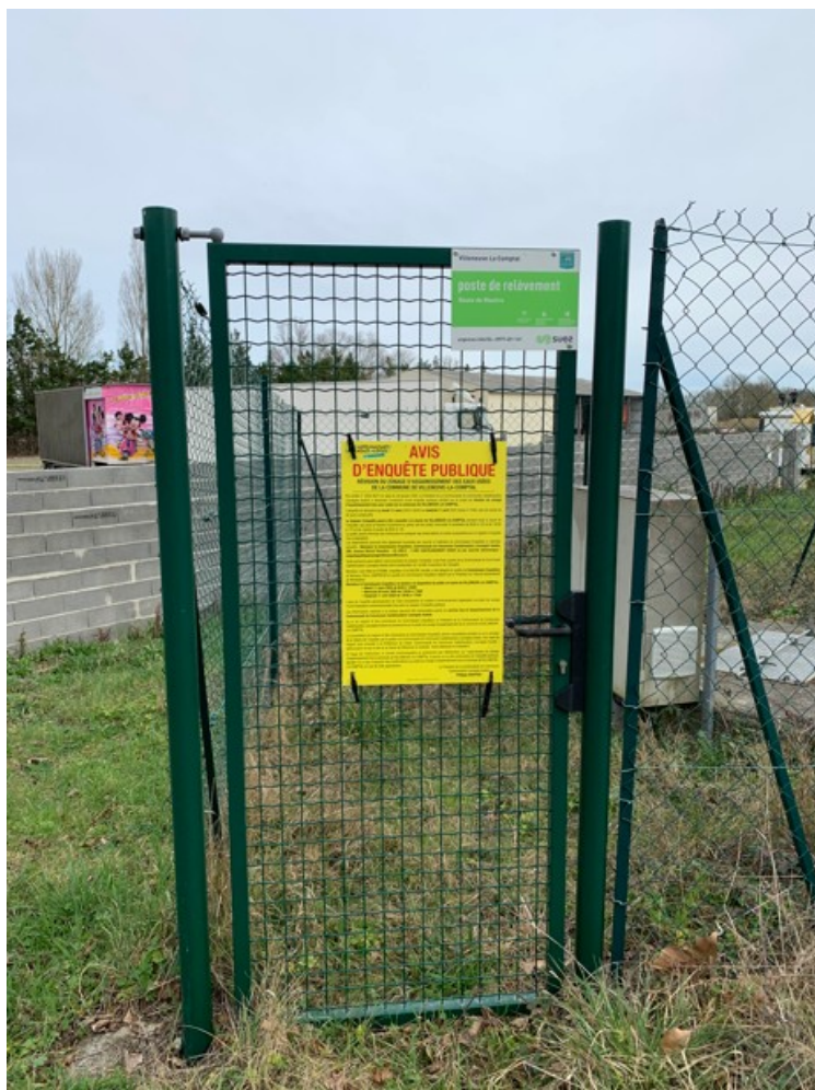
Affichage au poste de relevage de la commune de Villeneuve-la-Comptal
