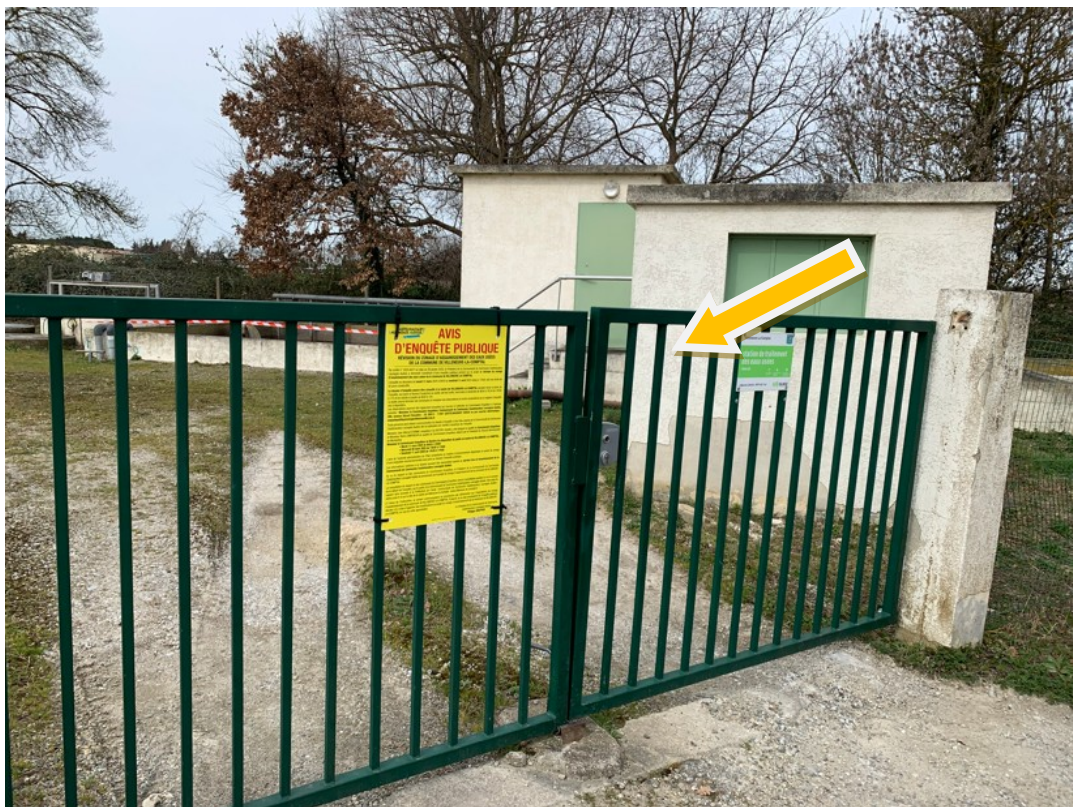
Vue de l'entrée de la station d'épuration de La commune de Villeneuve-la-Comptal
