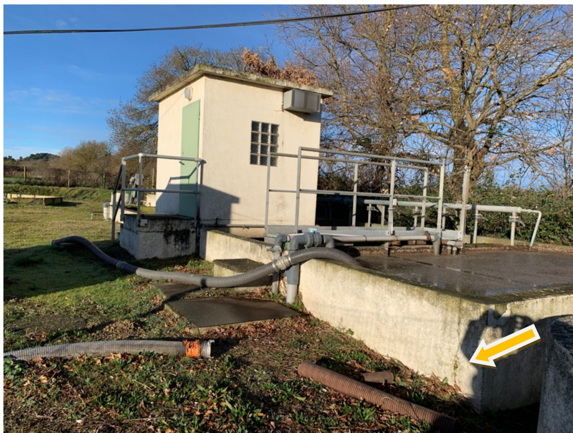
Vue de l'état de la station d'épuration de La commune de Villeneuve-la-Comptal
