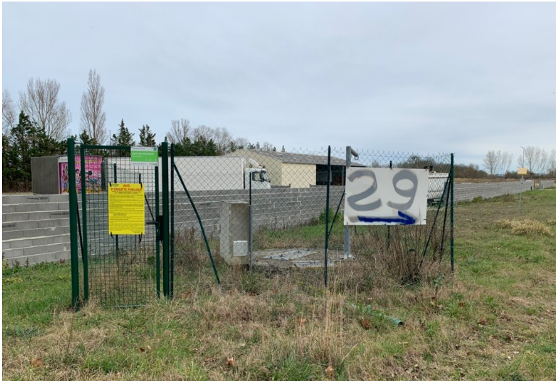
Vue de l'entrée de la poste de relevage de la commune de Villeneuve-la-Comptal
